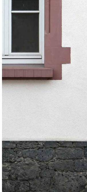
Basaltsockel, Fenstergewände aus Sandstein, Putzfassade
